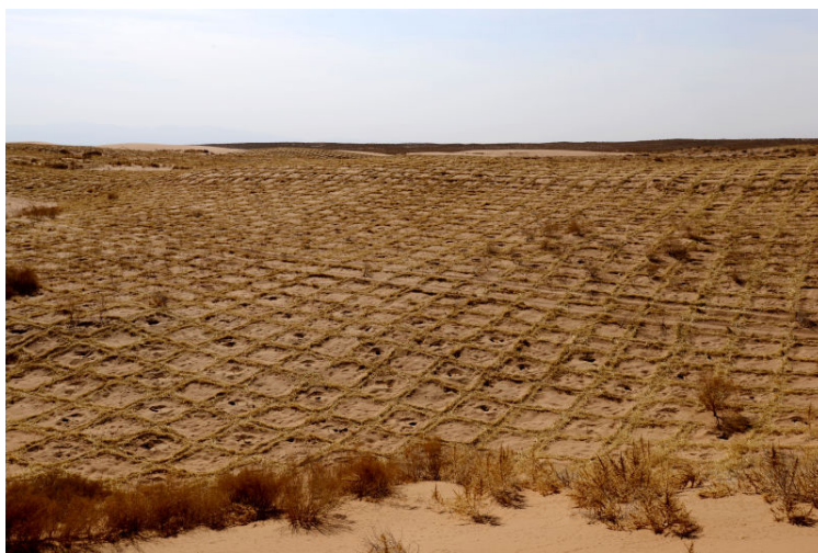
2014年SEE公益治沙基地采用工程固沙+生物固沙的方式对流动沙丘进行治理 拍摄时间2014年4月
