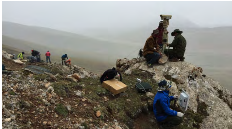
在崖壁上安装云台摄像机和无线发送器及太阳能电源
